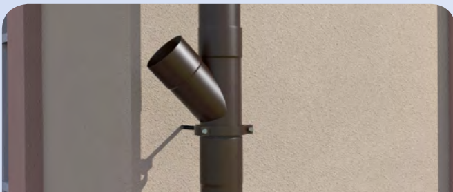
13. W zależności od potrzeb zamontuj trójnik, montując go do ściany przy pomocy obejm fixo. Zapewnij ok. 5 mm luzu.
